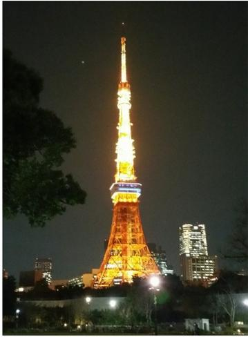
エッフェル塔は鍛鉄(れんてつ)、東京タワーは鋼鉄でできているように、鍛鉄は鋼鉄のような粘りがない為、エッフェル塔はそのうちグニヤリと曲がってしまうのではないかと危惧されましたが、最新の構造シミュレーション調査の結果、非常に頑丈であり、優れた設計であったことが確かめられていたようです。
